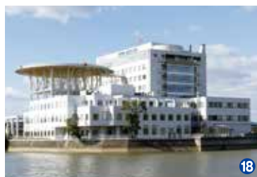
社会医療法人財団 池友会 新行橋病院 〒824-0026 福岡県行橋市道場寺 1411 TEL:0930-24-8899 / 246 床(急性期+回復期)
